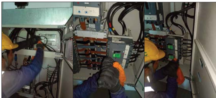
เช็ดทำความสะอาดอุปกรณ์ พร้อมฉีดน้ำยาไล่ความชื้น
