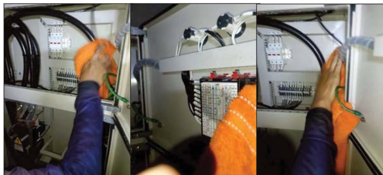
กวดขันยึดแน่นน็อต พร้อมใช้ปากกามาร์กสัญลักษณ์แสดงจุดต่ออุปกรณ์
