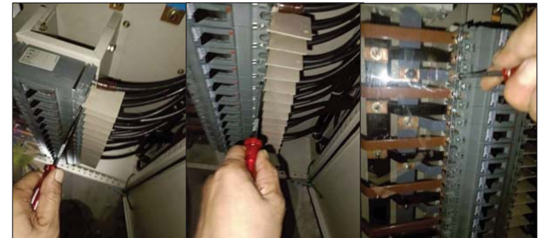
กวดขันอัตโนมัติ พร้อมใช้ปากกามาร์กสัญลักษณ์แสดงจุดต่ออุปกรณ์
