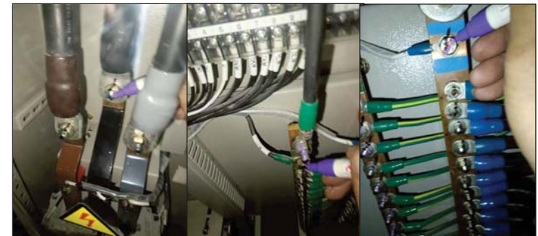
ใช้ปากกามารักสัญลักษณ์พร้อมกวดขันอัดแน่นข้อต่ออุปกรณ์
