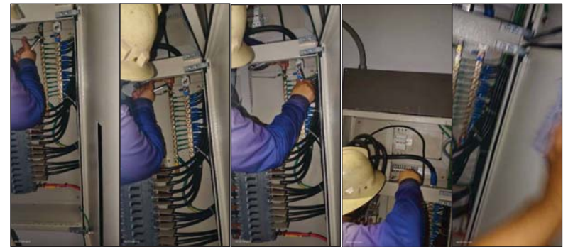
เช็คทำความสะอาดอุปกรณ์ พร้อมกวดขันยึดแน่นน็อตจุดต่อ
