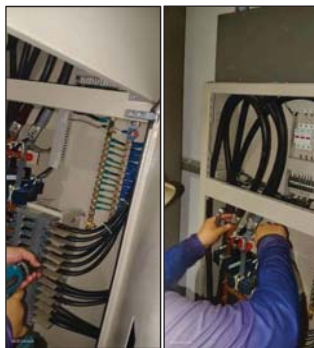
เช็ดทำความสะอาดอุปกรณ์ พร้อมกวดขันยึดแน่นน็อตจุดต่อ
