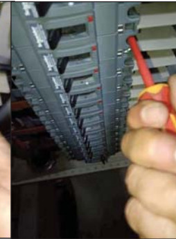
กวดขันยึดแน่นน็อต พร้อมใช้ปากกามาร์กสัญลักษณ์แสดงจุดต่ออุปกรณ์
