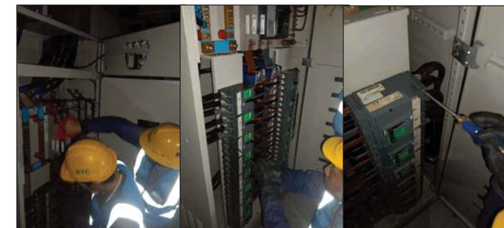
เช็คทำความสะอาดอุปกรณ์ พร้อมกวดขันยึดแน่นือตจุดต่อ
