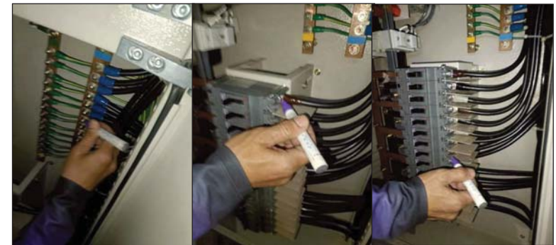
เช็ตทำความสะอาดอุปกรณ์ พร้อมกวดขันอัดแน่นน็อตจุดต่อ
