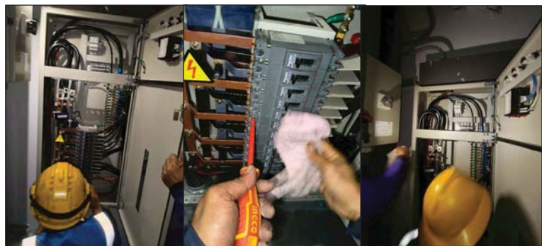
เช็ดทำความสะอาดอุปกรณ์ พร้อมกวดขันยึดแน่นน็อตจุดต่อ
