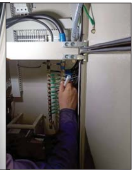
กวดขันยึดแน่นน็อต พร้อมใช้ปากกามาร์กสัญลักษณ์แสดงจุดต่ออุปกรณ์
