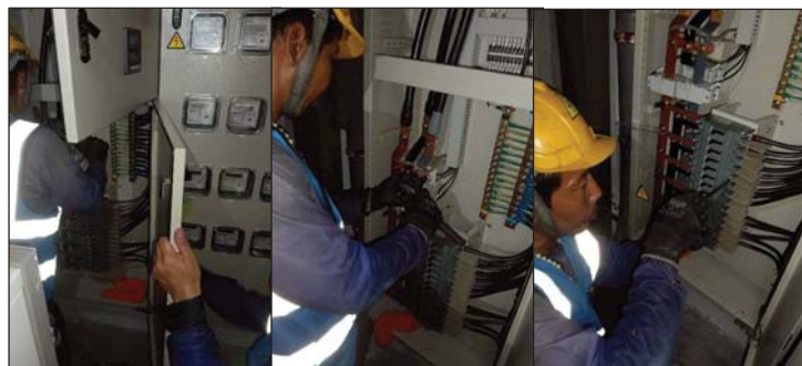
ทำความสะอาดอุปกรณ์ พร้อมกวดขันยึดแน่นือตจุดต่อ
