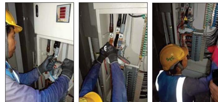
ทำความสะอาดอุปกรณ์ พร้อมกวดขันยึดแน่นข้อต่อ
