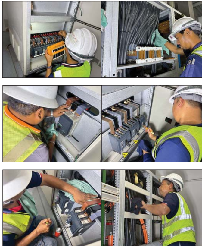
เช็ดทำความสะอาดอุปกรณ์ พร้อมฉีดน้ำยาไล่ความชื้น
