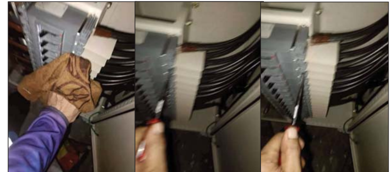
เช็ดทำความสะอาดอุปกรณ์ พร้อมกวดขันอัดแน่นน็อตจุดต่อ
