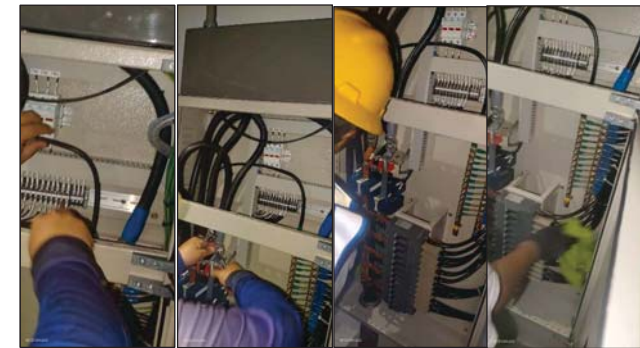
ทำความสะอาดอุปกรณ์ พร้อมฉีดน้ำยาไล่ความชื้น
