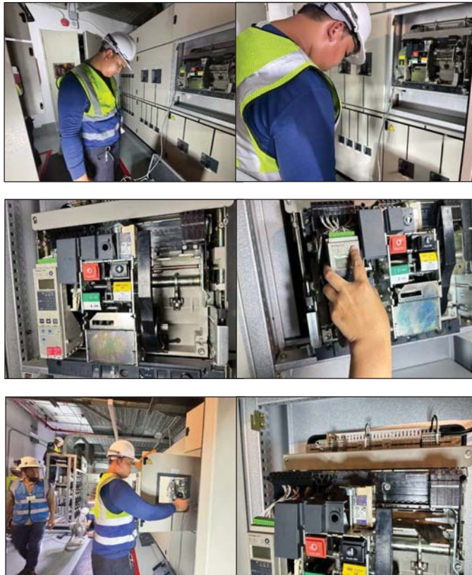
ถอดหน้ากากอุปกรณ์ เพื่อตรวจสอบกลไกการทำงาน
