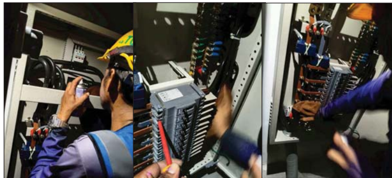
เช็คทำความสะอาดอุปกรณ์ พร้อมกวาดฝุ่นอัดแน่นข้อต่ออุปกรณ์
