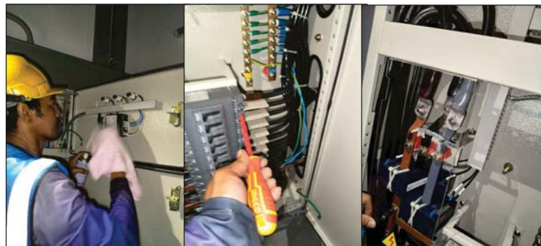
เช็คทำความสะอาดอุปกรณ์ พร้อมฉีดน้ำยาไล่ความชื้น
