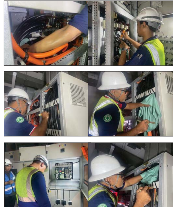
ใช้แปรงขัดทำความสะอาดอุปกรณ์ตู้ MDB
