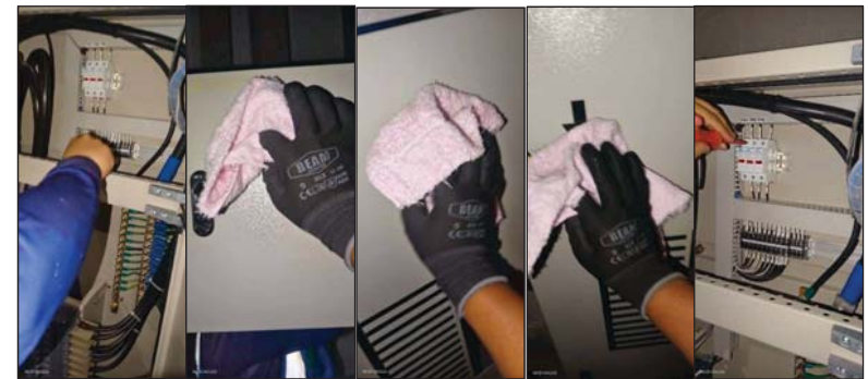
เช็ดทำความสะอาดอุปกรณ์ พร้อมฉีดน้ำยาไล่ความชื้น
