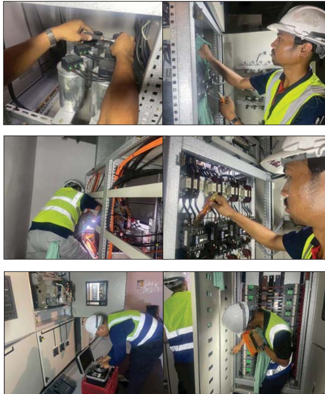
ทำความสะอาดอุปกรณ์ พร้อมกวดขันยึดแน่นน็อตจุดต่อ
