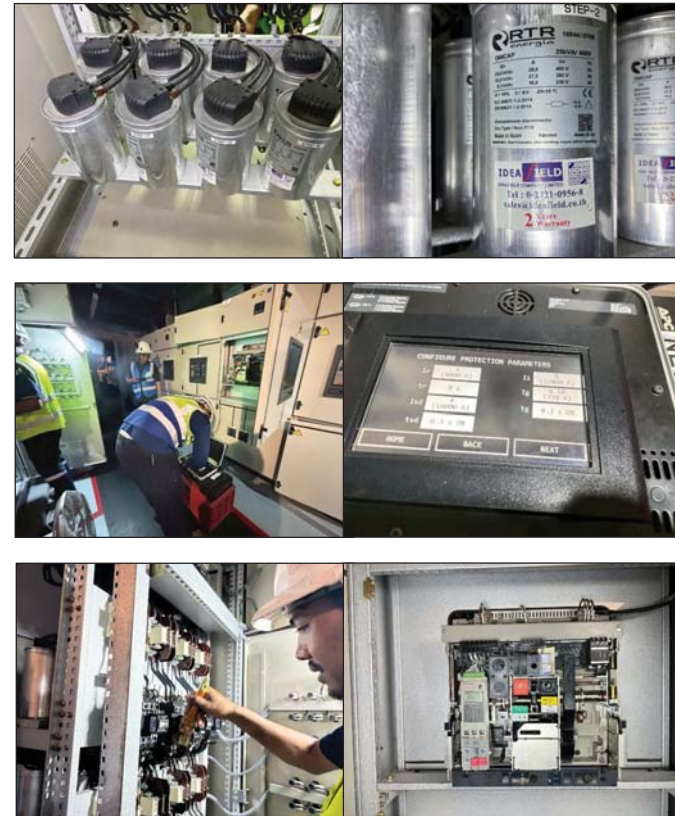
ถอดหน้ากาก ทำความสะอาดอุปกรณ์ Main air circuit breaker
