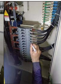
กวดขันยึดแน่นน็อต พร้อมใช้ปากกามาร์กสัญลักษณ์แสดงจุดต่ออุปกรณ์
