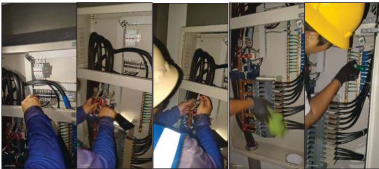
ทำความสะอาด พร้อมกวดขันอัดแน่นข้อต่อจุดต่ออุปกรณ์
