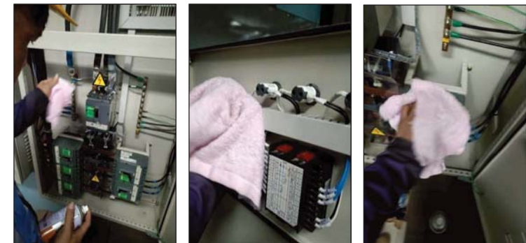
เช็ดทำความสะอาดอุปกรณ์ พร้อมฉีดน้ำยาไล่ความชื้น
