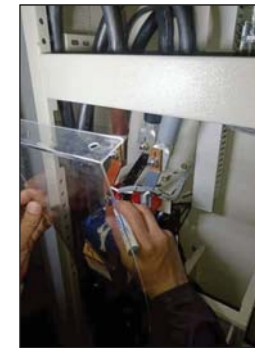
กวดขันยึดแน่นน็อต พร้อมใช้ปากกามาร์กสัญลักษณ์แสดงจุดต่ออุปกรณ์
