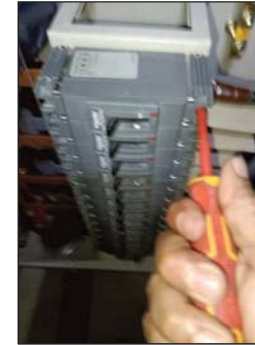
กวดขันยึดแน่นน็อต พร้อมใช้ปากกามาร์กสัญลักษณ์แสดงจุดต่ออุปกรณ์
