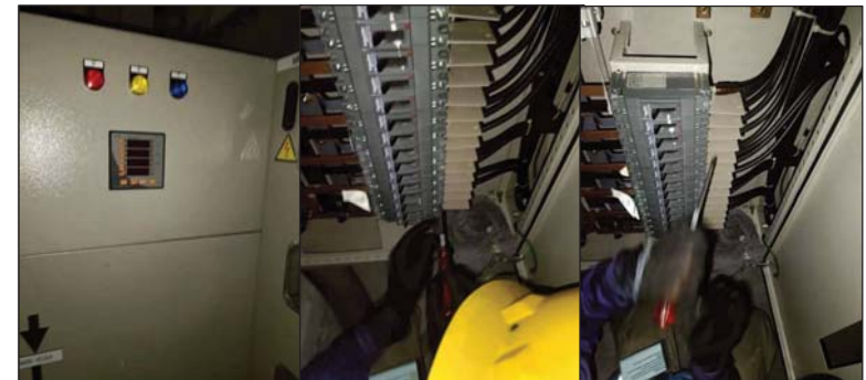
กวดขันยึดแน่นข้อต่อจุดต่ออุปกรณ์
