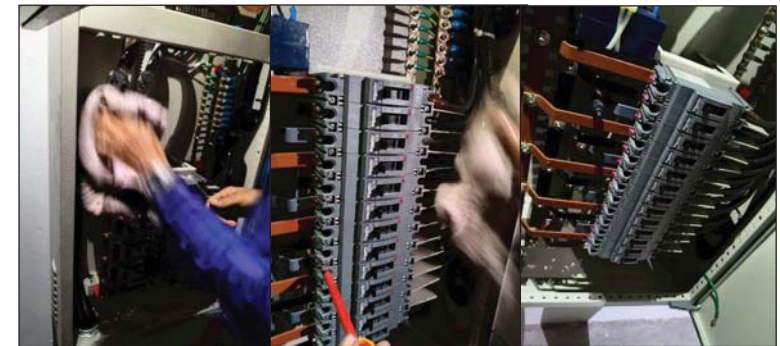
เช็ดทำความสะอาดอุปกรณ์ กวาดขี้ฝุ่นอัดแน่นจุดต่อ
