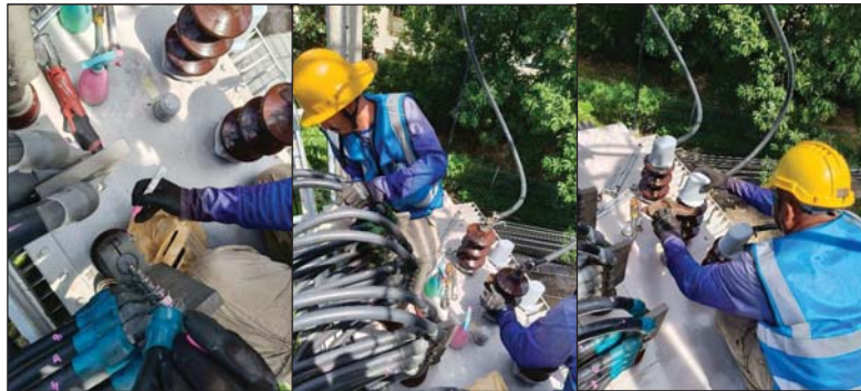
เช็ดทำความสะอาดอุปกรณ์หม้อแปลงไฟฟ้า พร้อมกวดขันน็อตแน่นือตจุดต่อ
