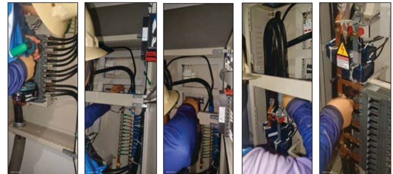
ทำความสะอาด พร้อมกวาดฝุ่นอัดแน่นข้อต่ออุปกรณ์
