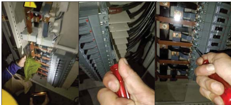
ทำความสะอาดอุปกรณ์ พร้อมกวดขันอัดแน่นข้อต่ออุปกรณ์
