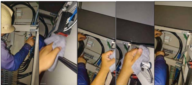
เช็คทำความสะอาดอุปกรณ์ พร้อมกวดขันยึดแน่นน็อตจุดต่อ
