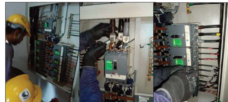
เช็คทำความสะอาดอุปกรณ์ พร้อมกวดขันยึดแน่นจุดต่อ
