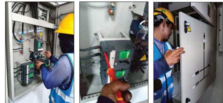
ทำความสะอาดอุปกรณ์ พร้อมกวดขันยึดแน่นน็อตจุดต่อ
