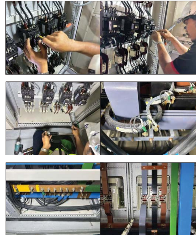
ทำความสะอาด พร้อมกวดขันแน่นน็อตจุดต่ออุปกรณ์
