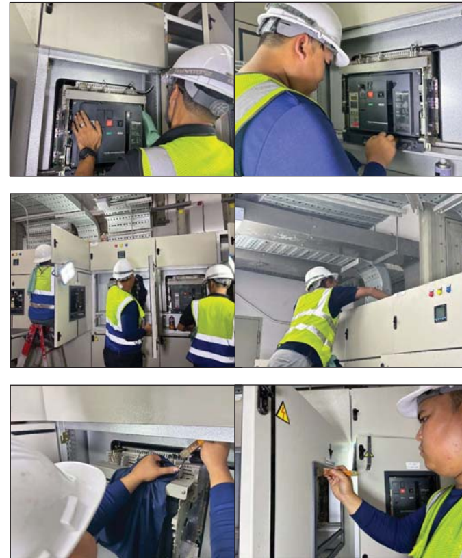
ใช้แปรงขัดทำความสะอาดอุปกรณ์ Main air circuit breaker
