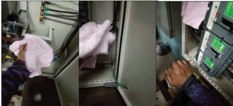
เช็ดทำความสะอาดอุปกรณ์ พร้อมกวัดขันน็อตแน่นน็อตจุดต่อ
