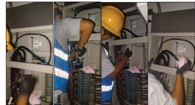
เช็คทำความสะอาดอุปกรณ์ พร้อมกวดขันยึดแน่นน็อตจุดต่อ
